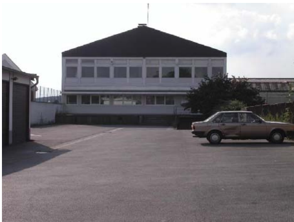
Das Gebäude, in dessen 1.OG sich der Raceway befindet, steht ein wenig zurück von der Straße
